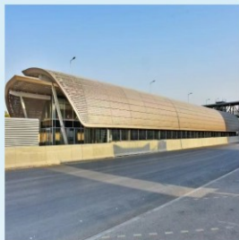
沙特BRT Saudi BRT
