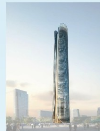
埃及新開羅 New Cairo CBD, Egypt
